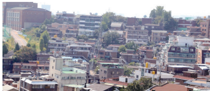
서울 용산구 한남5구역이 최고 높이 23층, 2555가구 단지로 탈바꿈한다. 사진은 한남5구역. 박미나 기자
