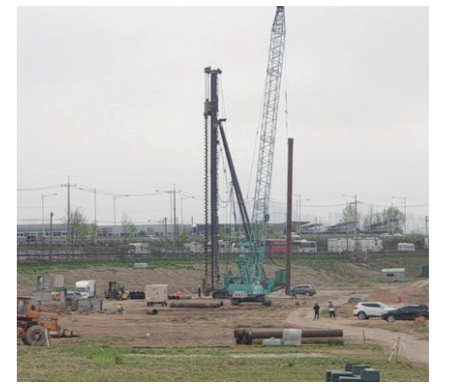
한강시네폴리스 진입도로 풍곡C구간 착공. 김포시
