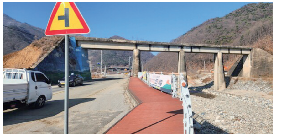
철거 작업 중인 기존 문경선 조령천 제2교.
