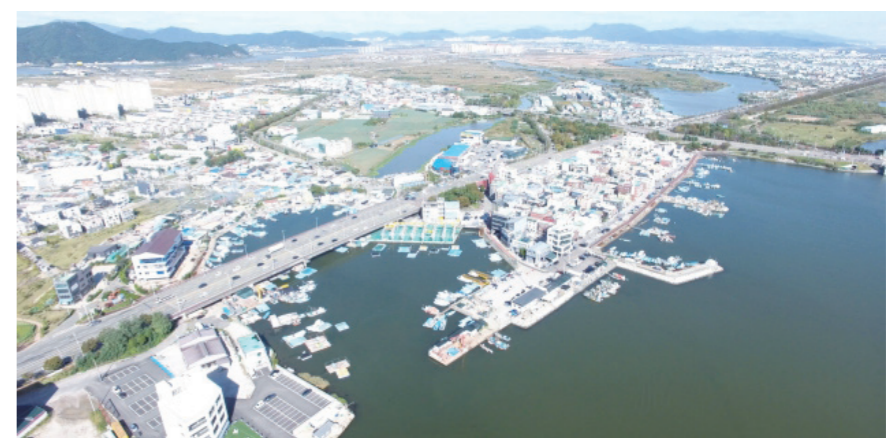
해양수산부는 '2025년도 어촌신활력증진사업' 대상지 25곳을 선정해 발표했다. 대상지로 선정된 부산 강서구 명지항 일대. 부산시
